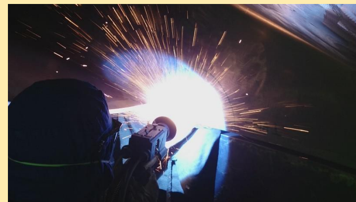
Aspersion Térmica ASP
